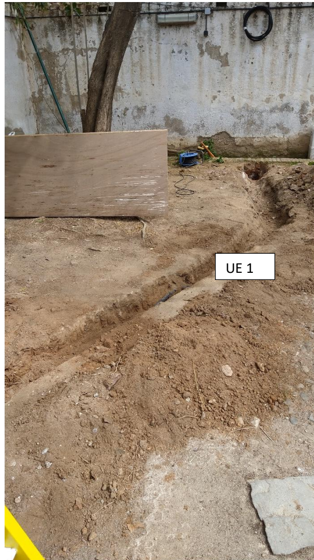
Fig.-19- Imatge general de la rasa, un cop acabada.
