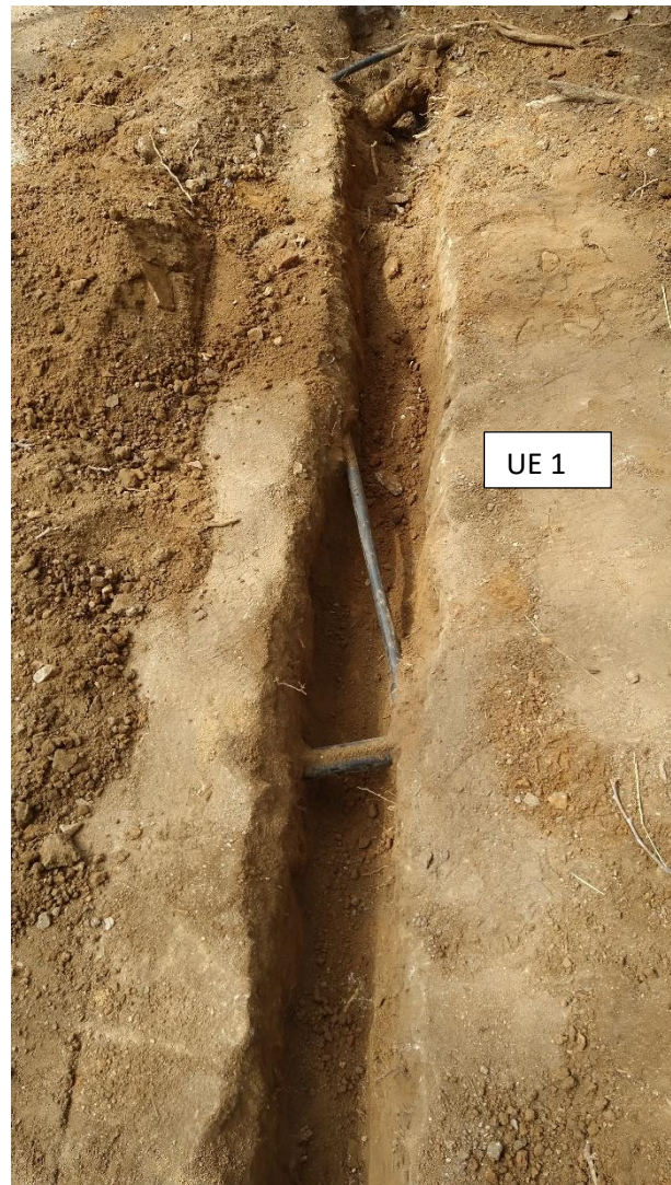
Fig.18.- Imatge de la rasa on s'observen els diferents serveis que la travessen
