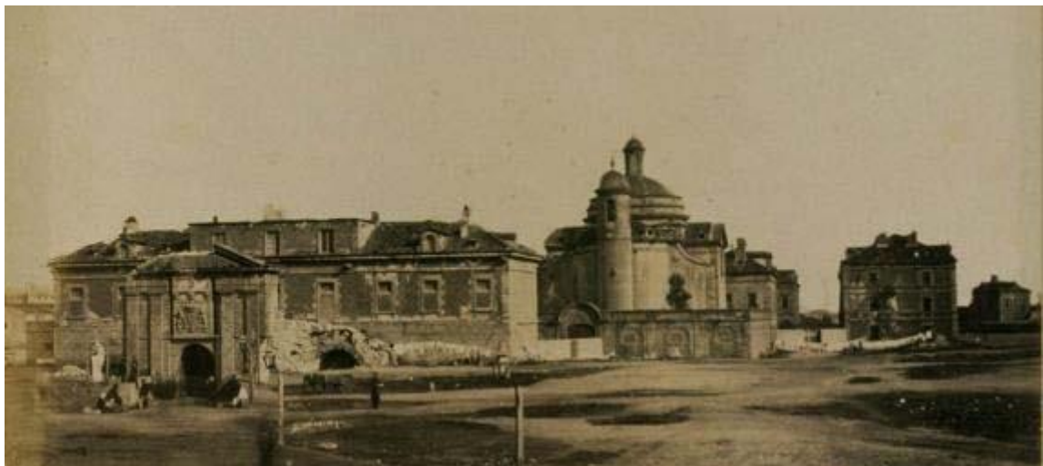
Fig.14.-La Ciutadella en procés d'enderroc. Fotografia de Joan Martí de l'any 1870 (AFB)
